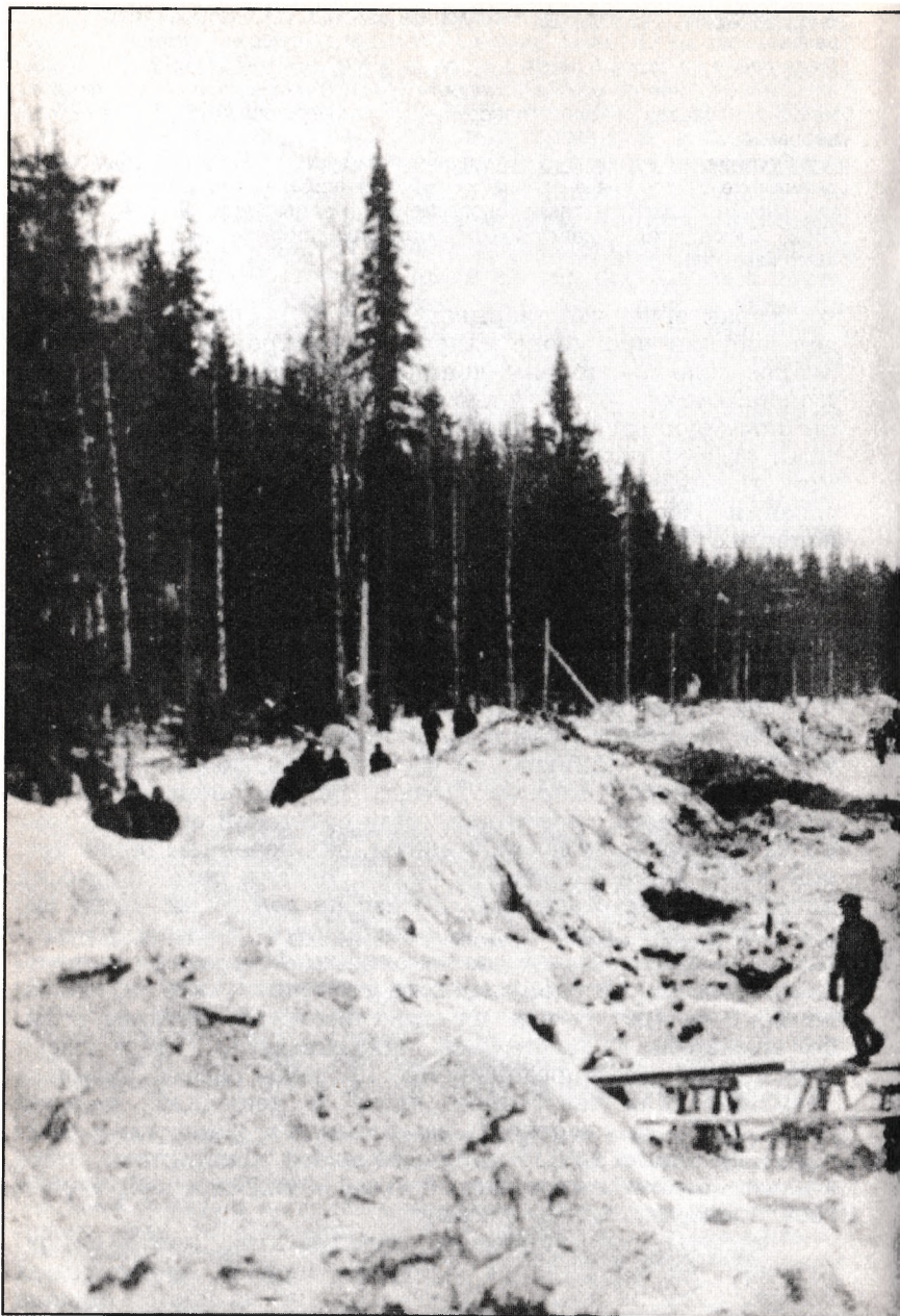
Строительство Широковской ГЭС. Производство земполотна на строительстве железнодорожной ветки. Март 1943 г.
