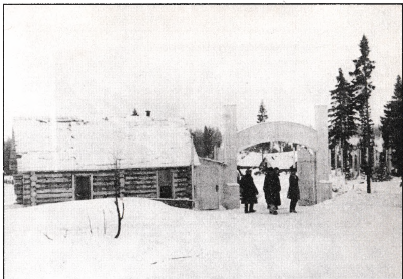
Строительство Понышевской ГЭС. 1-е отделение Понышлага (вахта). Март 1943 г.
