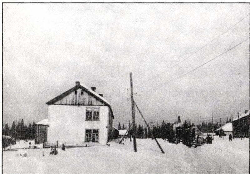
Строительство Широковской ГЭС. 2-е отделение Ширлага. Март 1943 г.
