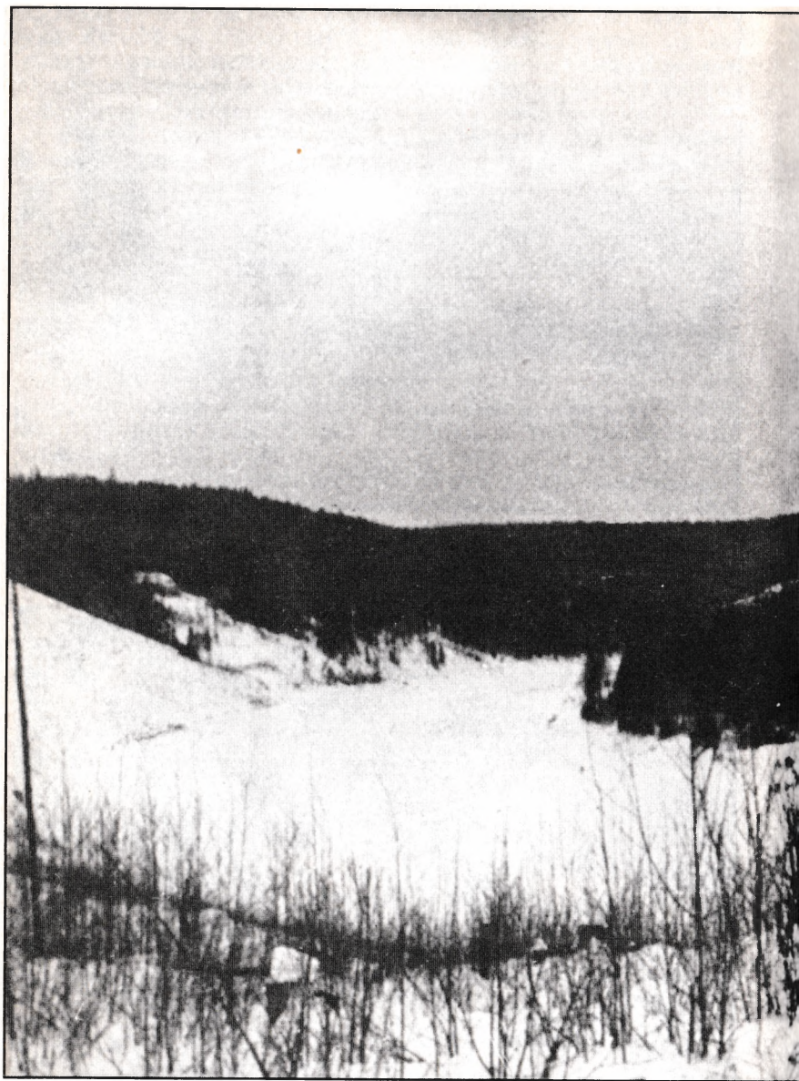
Строительство Поньшевской ГЭС. Общий вид реки Чусовой. Март 1943 г.
