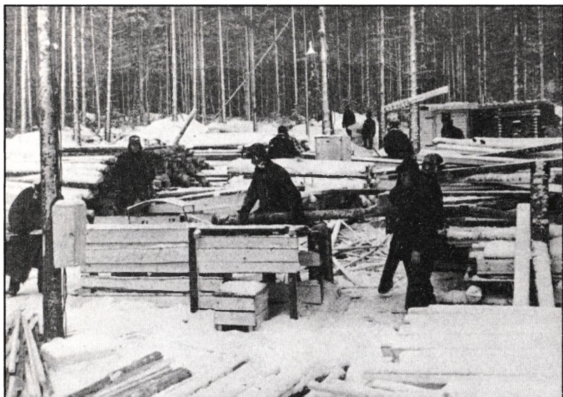
Строительство Широковской ГЭС. Шпалорезка. Март 1943 г.
